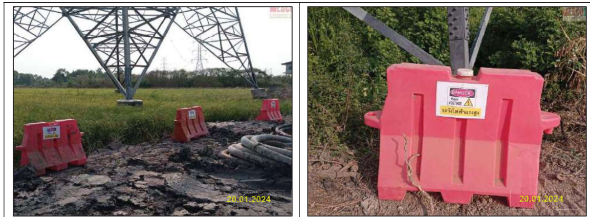
ก) การป้องกันฐานของเสาส่งไฟฟ้าแรงสูง
