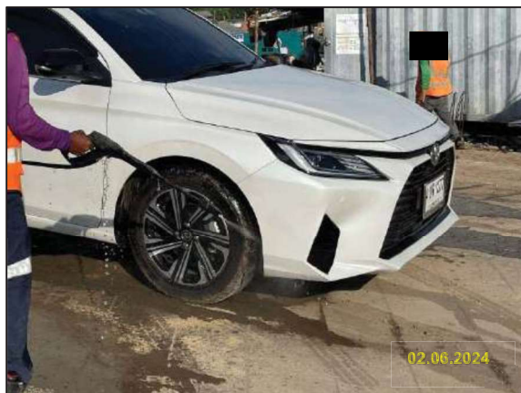
รูปที่ 2-8 การจัดทำพื้นที่ล้างล้อพร้อมทั้งล้างทำความสะอาดเศษดิน และเศษโคลนที่ติดกับล้อรถ ก่อนออกจากพื้นที่เก็บกองท่อ (Stock Yard) และพื้นที่ก่อสร้าง
