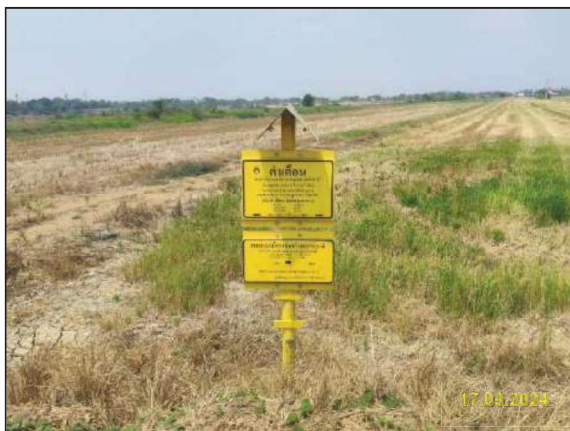
รูปที่ 2-36 ป้ายเตือนแสดงตำแหน่งแนววางท่อส่งก๊าซฯ ของโครงการ
