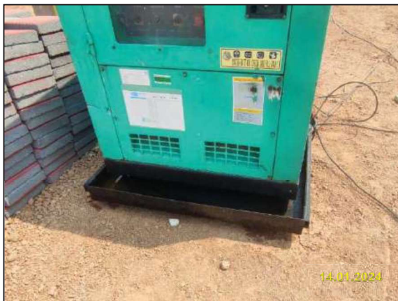
ก) อุปกรณ์ใช้ดูดซับน้ำมัน และสารเคมี
