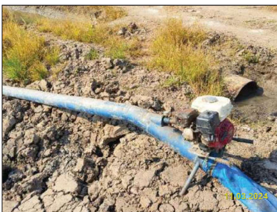
รูปที่ 2-22 เตรียมเครื่องสูบน้ำแรงดันต่ำ สำรองไว้ใช้งานตลอดระยะเวลาการก่อสร้าง
