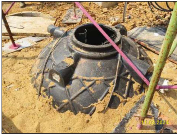
รูปที่ 2-14 การติดตั้งระบบบำบัดน้ำเสียสำเร็จรูปที่ได้มาตรฐาน / บ่อพักน้ำทิ้งโครงการบริเวณสำนักงาน ของโครงการ
