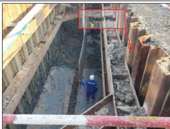
รูปที่ 2-10 การติดตั้ง Sheet Pile หรือ Trench Box เพื่อป้องกันการพังทลายของดิน
