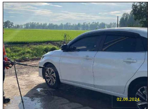
รูปที่ 2-8 การจัดทำพื้นที่ล้างล้อพร้อมทั้งล้างทำความสะอาดเศษดิน และเศษโคลนที่ติดกับล้อรถ ก่อนออกจากพื้นที่เก็บกองท่อ (Stock Yard) และพื้นที่ก่อสร้าง
